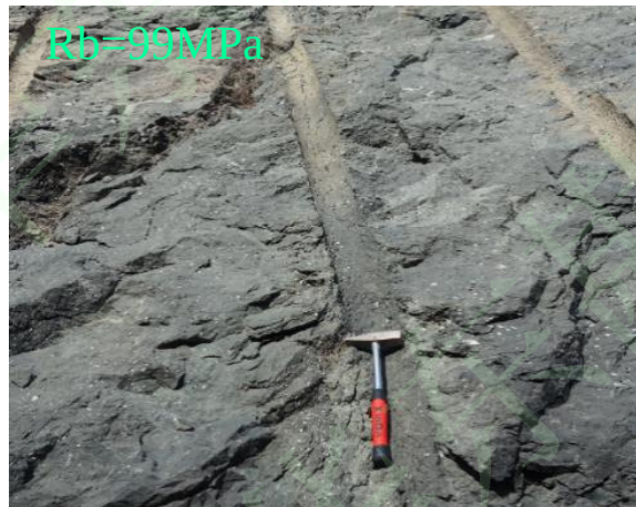
杏仁状玄武岩(大坝建基面)
