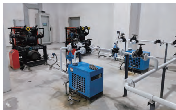
湖北新集水利枢纽项目 HUBEI XINJI WATER CONSERVANCY HUB PROJECT
